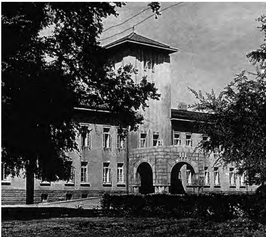
現在の吉林省延辺朝鮮族自治州龍井市内に残る在間島日本総領事館の建物（1922年建造）。地下に留置場、別棟に監獄があった。
